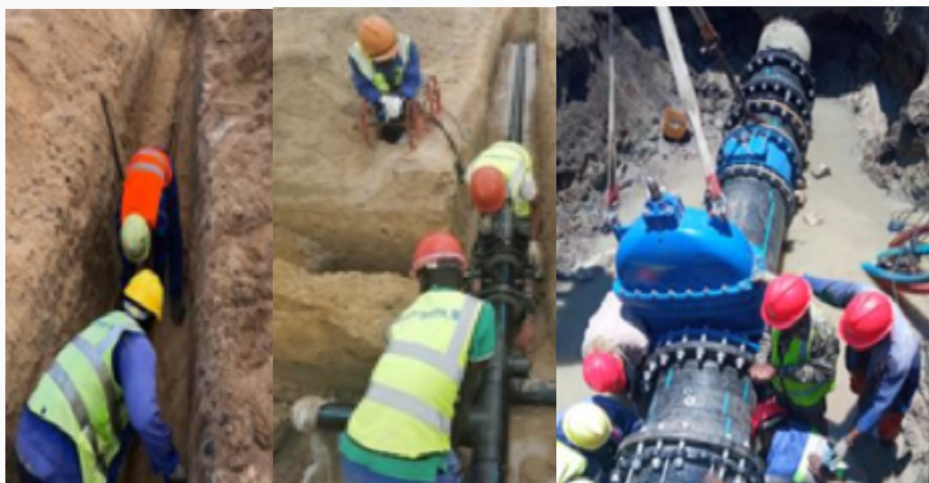
Instalação de rede (Cidade da Beira)
