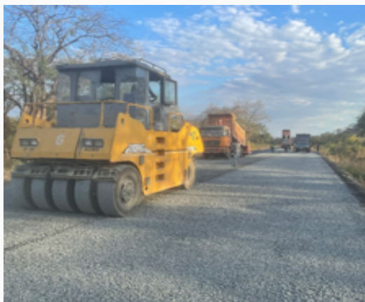
Asfaltagem da Estrada Roma -Negomano
