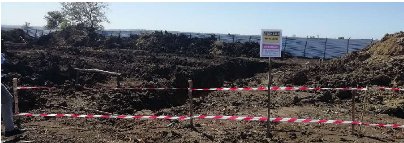
Abertura de caboucos para a construção do mercado e de espaço multiuso de Naminawe
