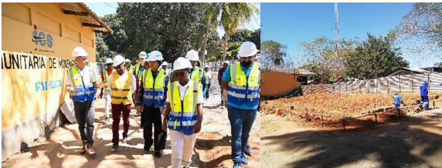
Abertura de caboucos do Centro Multimídia
